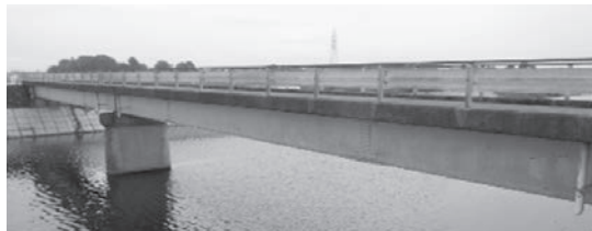
上梁橋（大字梁地内）
