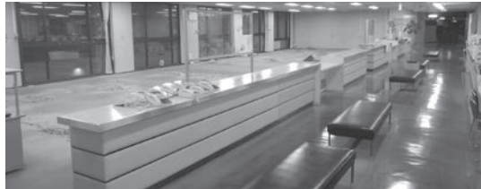
庁舎改修工事
