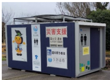
防災用コンテナ型トイレの例 (道の駅 うきは)
