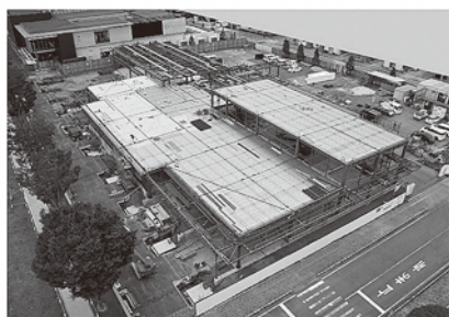
建設工事の様子
