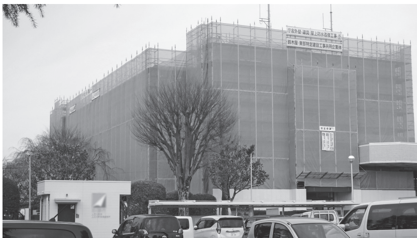
庁舎の改修工事の様子
