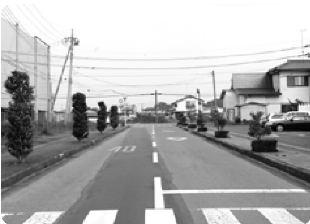
整備中の都市計画道路（富士山地区）
