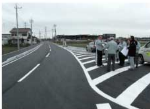
インターパーク南道路 (町道 3-121号線)
