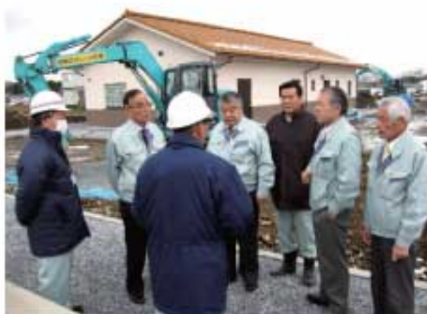
南部クリーンセンター
